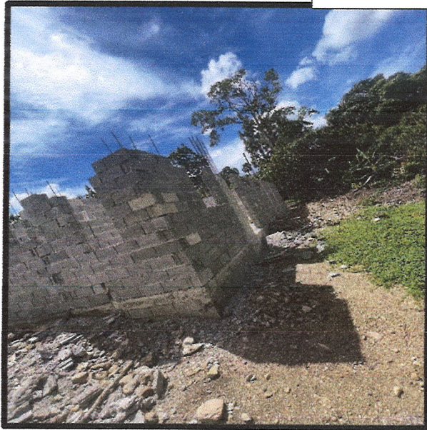
Estructura a nivel de losa de techo
