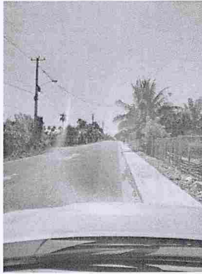
CARRETERA CABRERA-LA ENTRADA
