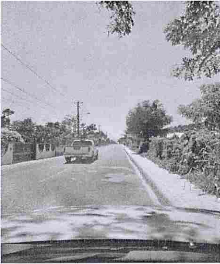
CARRETERA CABRERA-LA ENTRADA
