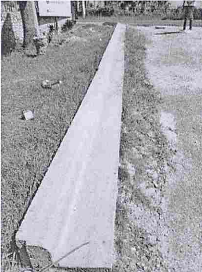
CARRETERA CABRERA-LA ENTRADA
