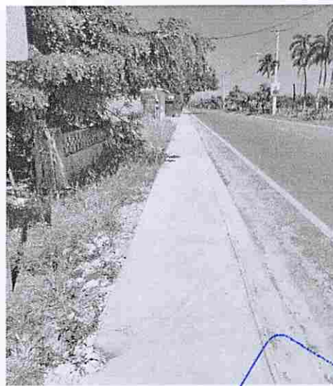
CARRETERA CABRERA-LA ENTRADA
