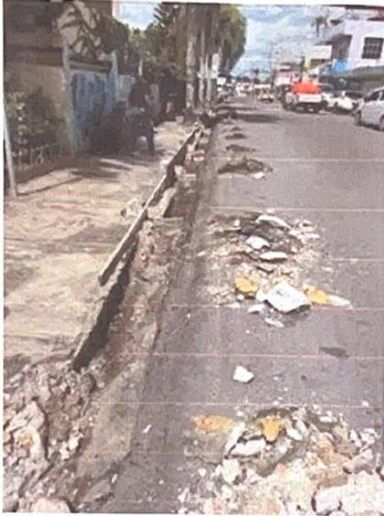
Se puede Observar la Preparación del terreno, removiéndolos los contenes que no estaban en condición, y las colocaciones de las plantillas de los contenes
