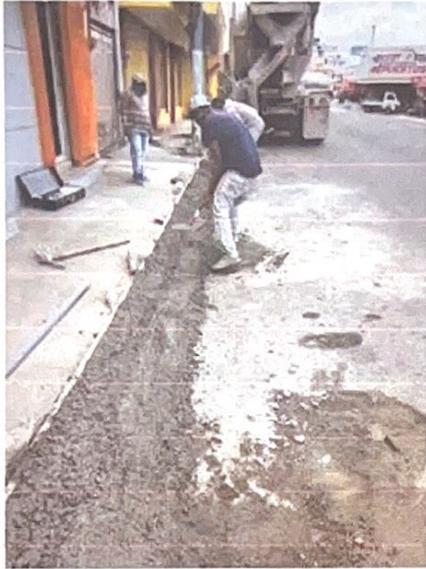
Para el vaciado de hormigón se utilizó hormigón Industrial 180 kg/cm<sup>2</sup>, dando mayor calidad y fue pulido a mano
