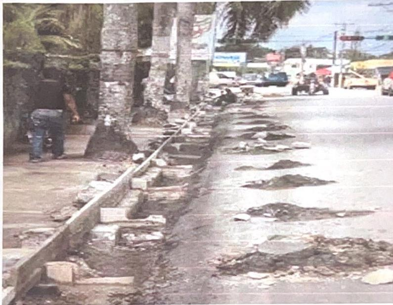
Las plantillas utilizadas para los contenes son de 30 cm de bombeo y 20 cms de peralte, observamos que por el aumento de el asfalto de la calzada se alzaron mas alto para que tenga la altura adecuada
